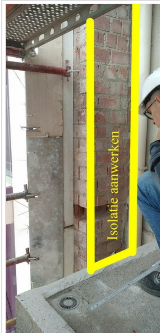
Penant blijft behouden; isolatie max. wordt er tegen aangewerkt
