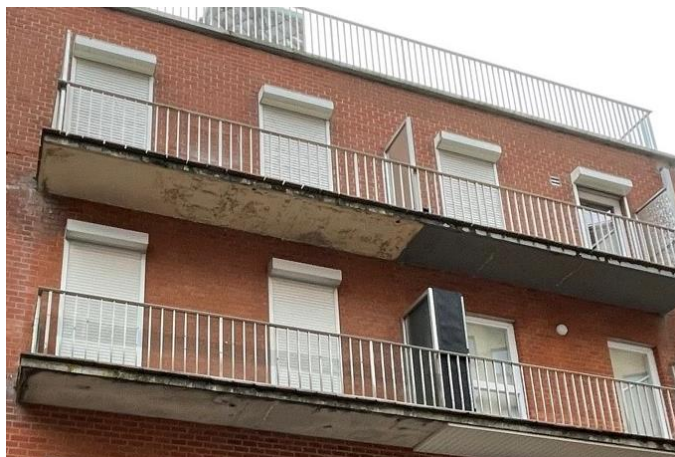
Vensterrolluiken aan de achtergevel
