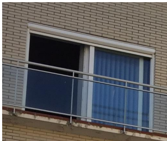
Screens aan de voorgevel
