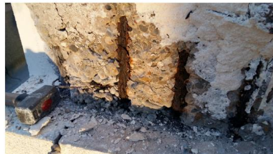
NA ONTMANTLING GEVELBEKLEDING
