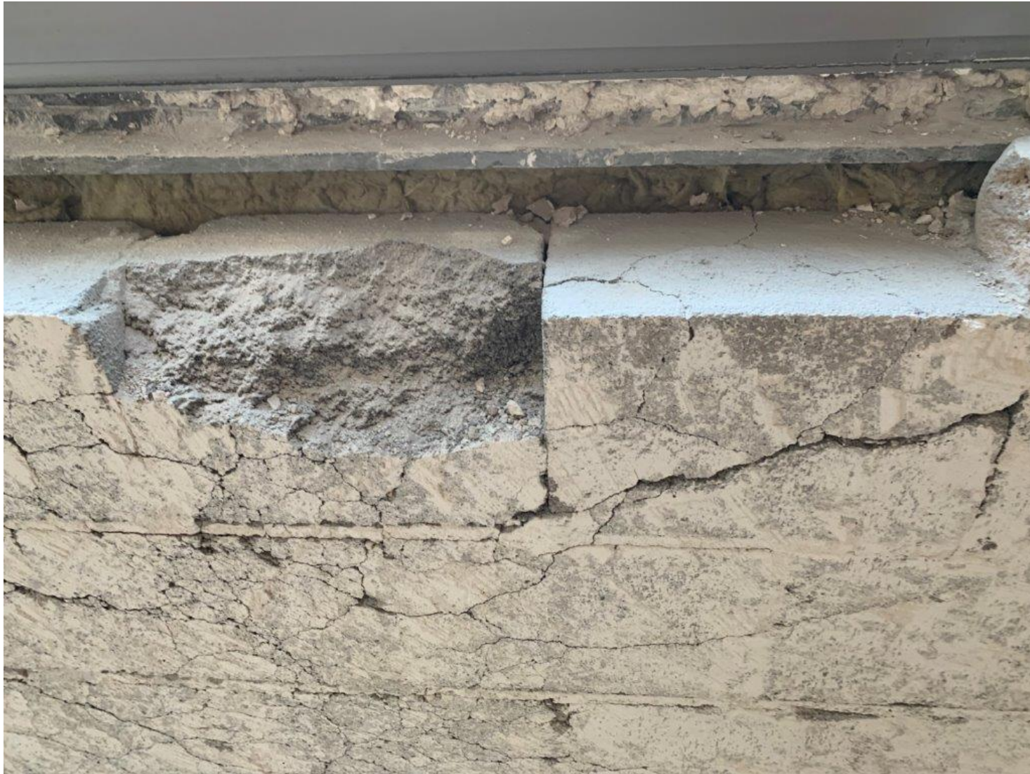
Schade bouwblokken met toevoeging STINOX
