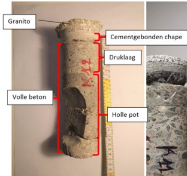
Kernboring K.1.2. – vloer 2 de verdieping
