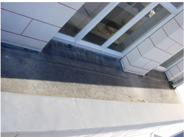
FOTO 277: Waterdichting balkon
