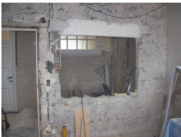
Figuur 106: Beeld van verbouwingswerken in één van de appartementen (Bron: privéarchief)
