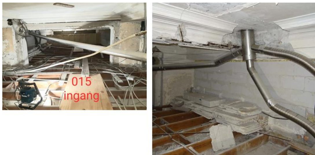
Figuur 118: Beeld van later ingebrachte technische leidingen en doorbrekingen (LMS Architecten)
