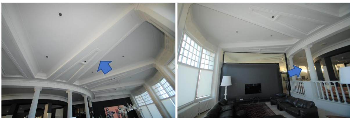
Figuur 67: Links de V-vormige balkstructuur in de rotonde waarvan één een zware betonnen ligger is en de andere een gepleisterde en gemoduleerde nepbalk en recht de ondersteunende betonnen kolommenstructuur (Erfgoedstudio)
