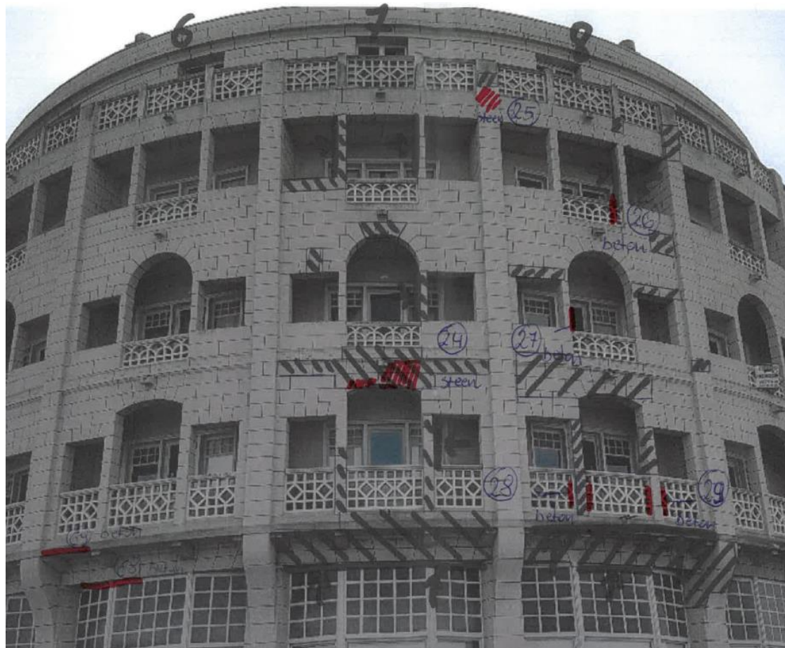
Figuur 44: Beeld zijde rotonde met rode aanduiding de uitgevoerde herstellingen met aanduiding type basismateriaal (MRT)
