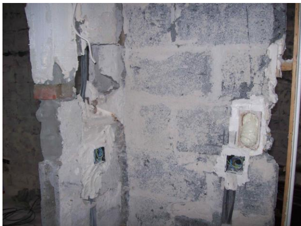
Figuur 108: Beeld van verbouwingswerken in één van de appartementen (Bron: privéarchief)
