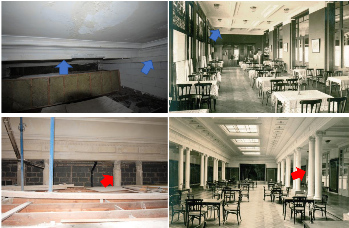
Figuur 66: Boven: links een recente foto genomen boven een verlaagd plafond van App. 0012 met beeld van de betonnen liggers aan de zijde van de Zeedijk en rechts een oude foto van de historische tearoom waarop de betonnen balkenstructuur in het plafond duidelijk zichtbaar is; onder: links huidige betonnen kolommen in de balzaal en rechts een oude foto met de dubbele zuilenrij van de oorspronkelijke balzaal (recente foto's: Erfgoedstudio; oude foto: privéarchief)
