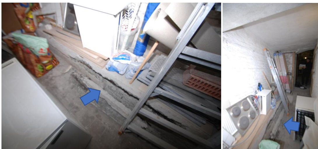
Figuur 71: Beeld van de betonnen verstijvingsbalk aangebracht op de vloer in berging 7 in de kelder (Erfgoedstudio)
