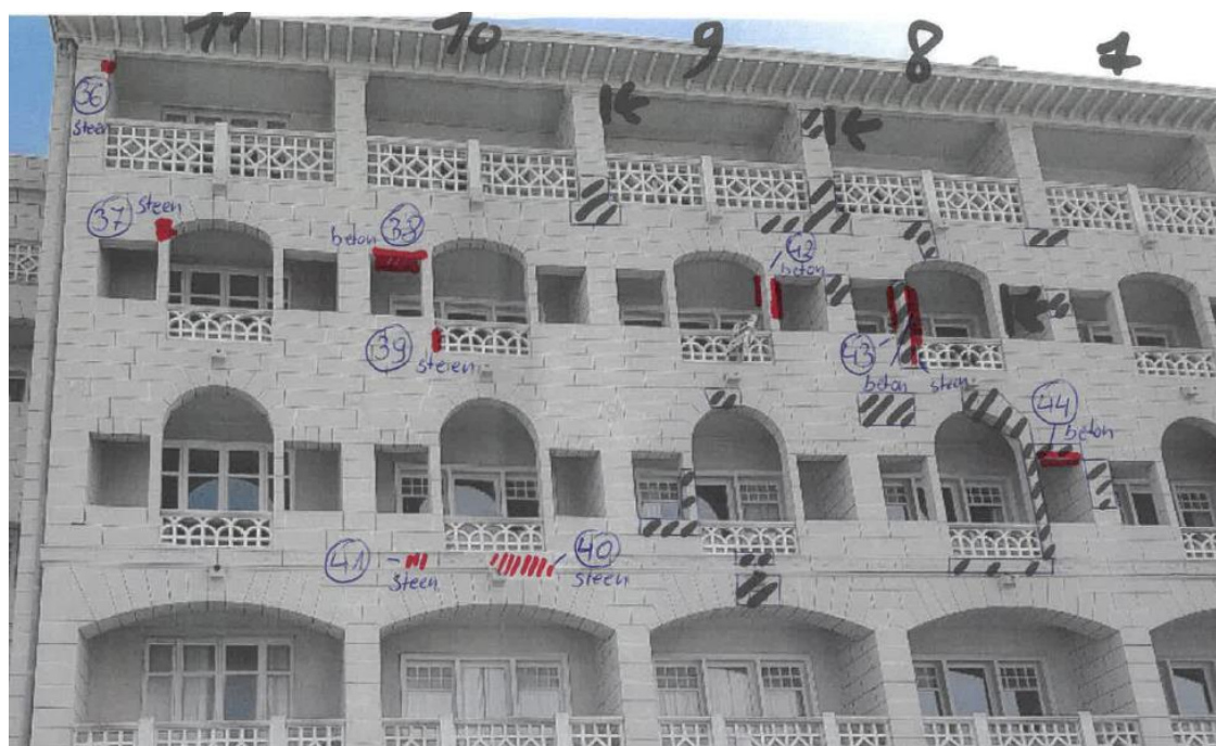
Figuur 45: Beeld zijde Zeedijk Bellevue met rode aanduiding de uitgevoerde herstellingen met aanduiding van de type van basismateriaal (MRT)
