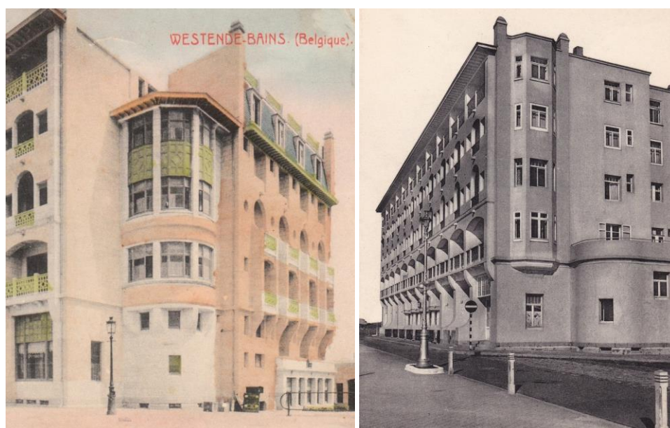
Figuur 13: Zuidwestelijke gevel Grand Hotel Bellevue - Links: afbeelding uit Bouwfase 1; rechts: afbeelding uit Bouwfase 2 (Bron: Archief gemeente Middelkerke en privéarchief van Jean-Luc Van Cauwenbergh).
