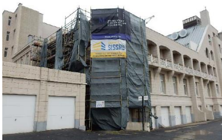
Figuur 42: Gevelstelling gevelzone deel 6 – zijde Mezenlaan (arch. Joost Beke)
