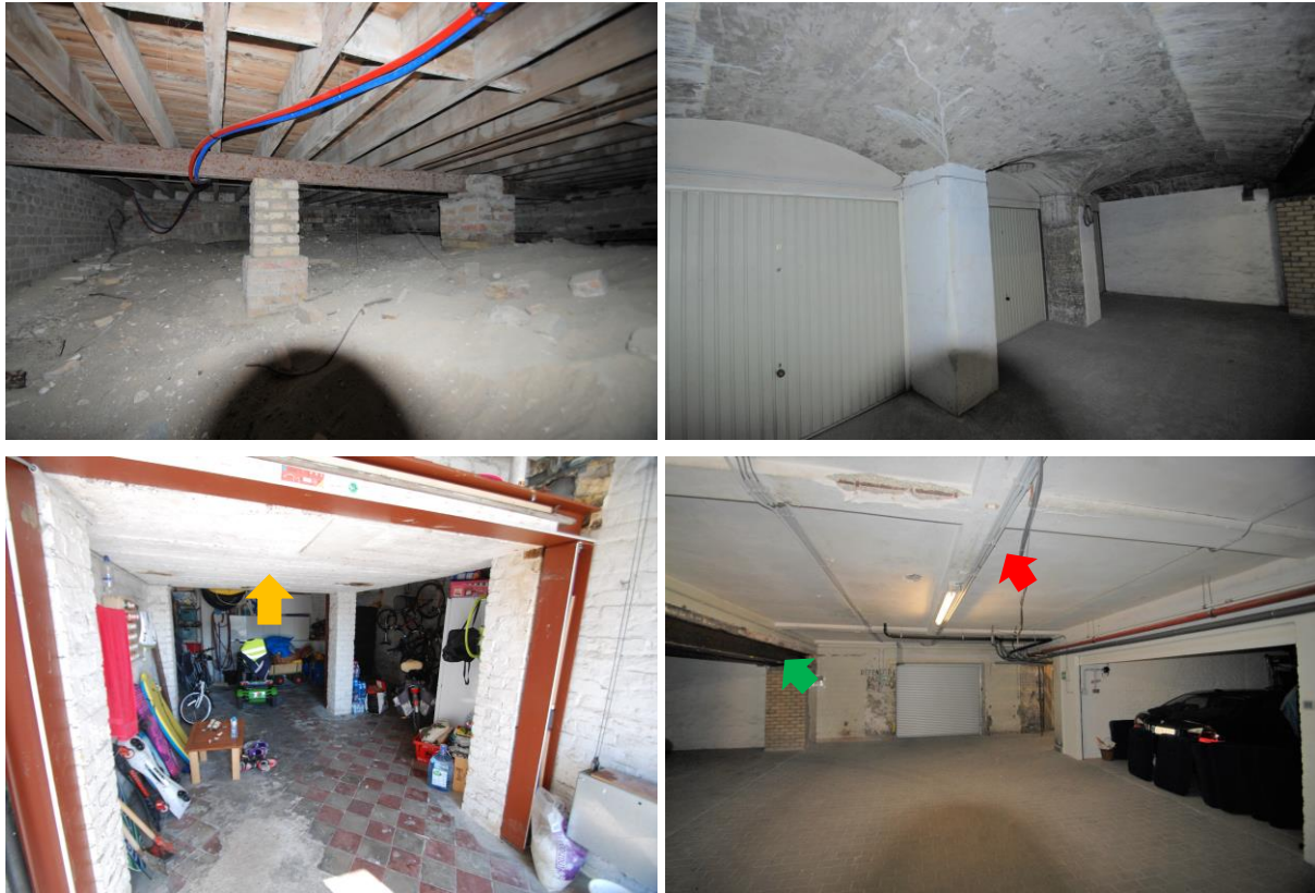
Figuur 70: Boven: links de houten roostering onder de tearoom van het gelijkvloers waarop de lichte tussenwanden van de appartementen van het gelijkvloers staan en rechts de oude waterciterne met gewelfstructuur centraal in de kelder waarop de kolommen van de balzaal worden gedragen; onder: links de betonnen draagstructuur in de kelder die de lichtschacht ondersteunt en rechts de betonnen roosterstructuur in de centrale ruimte of doorgang ten oosten van de historische waterciterne (Erfgoedstudio)
