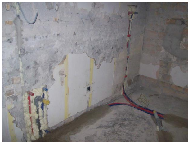
Figuur 107: Beeld van verbouwingswerken in één van de appartementen (Bron: privéarchief)
