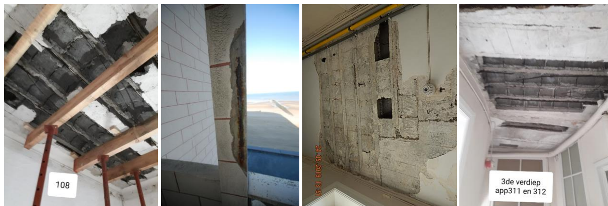
Figuur 1: Enkele voorbeelden van schadepatronen die geconstateerd werden aan verschillende draagstructuren (foto's: Erfgoedstudio en aannemer MRT)
