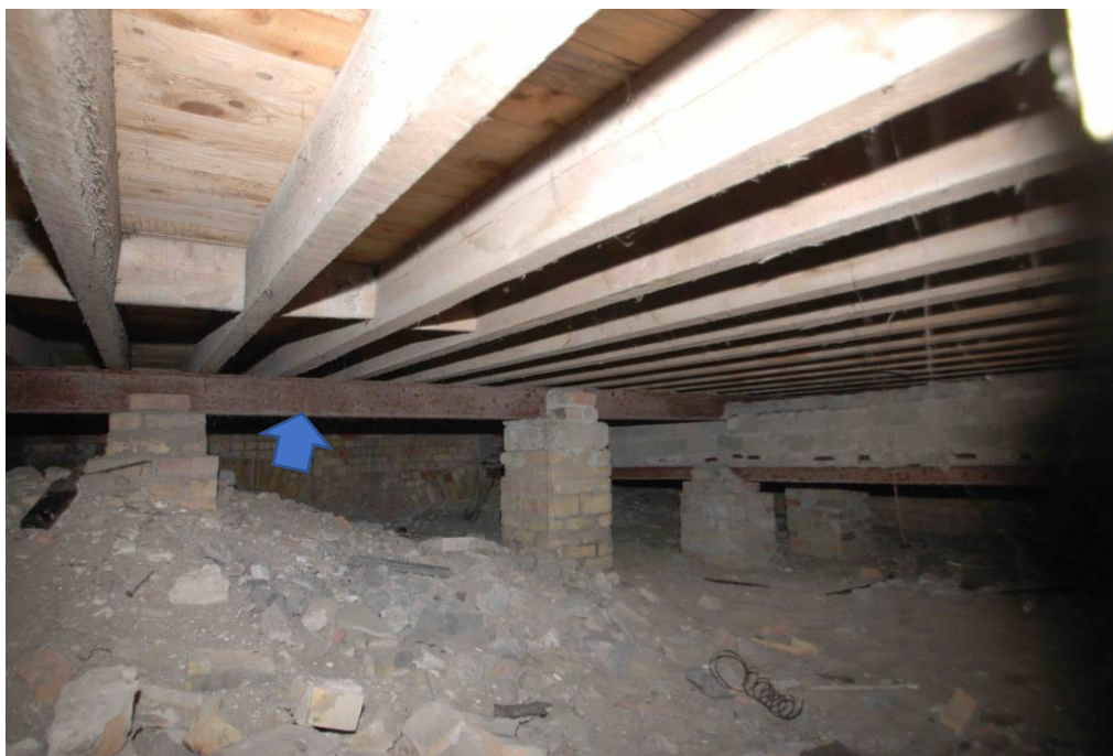
Figuur 110: Houten roostering in kelder onder de voormalige tearoom/bar (LMS Architecten)
