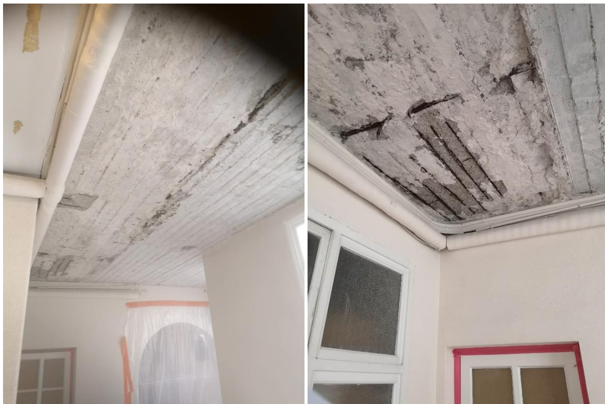
Figuur 20: Gestorte vloeren met verloren bekisting (Erfgoedstudio)
