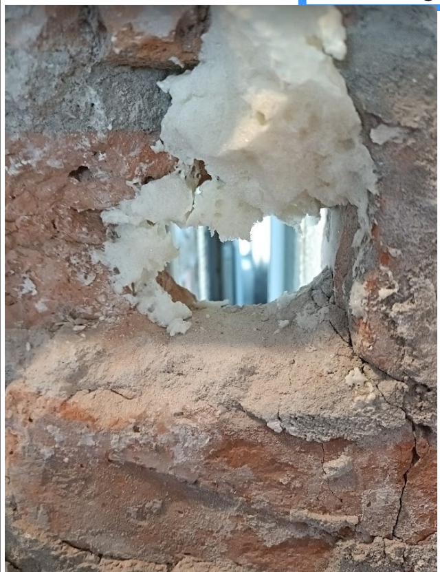
Door een gat kan men de liftonderdelen zien.
