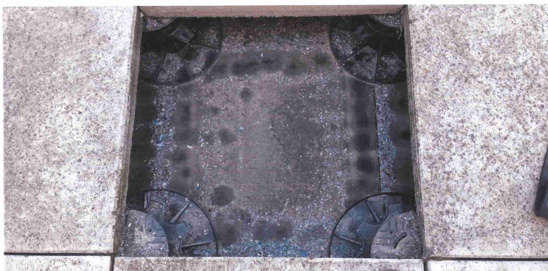
Dakterras vooraan : de afdrupsoren tonen aan dat er geen stagnatie is.
