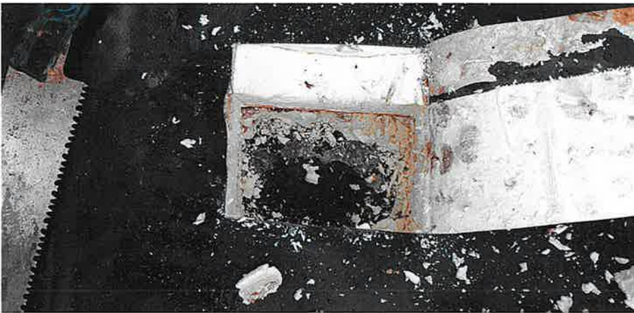
2 – 2 lagen isolatie met onderaan Resitrix dakdichting, in beperkte mate nat; isolatiedikte 12,5 cm
