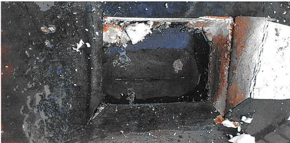
6 – Na droging van de onderste laag Resitrix is deze snede verdicht.
