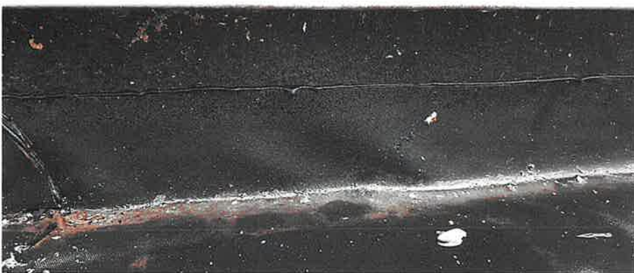
8 – Onder de alu muurkap is de eerste laag Resitrix doorgetrokken over de volledige breedte van de muurkop. De tweede laag, in tweede fase aangebracht, eindigt in opstand onder de alu muurkap.
