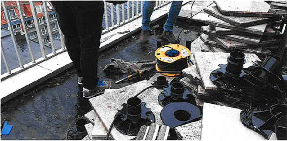
1 - Eerste sondering : ongeveer in het midden van het dak
