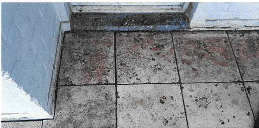
Terrastegels met dunne onderlinge voegen en aansluitend tegen de gevel
